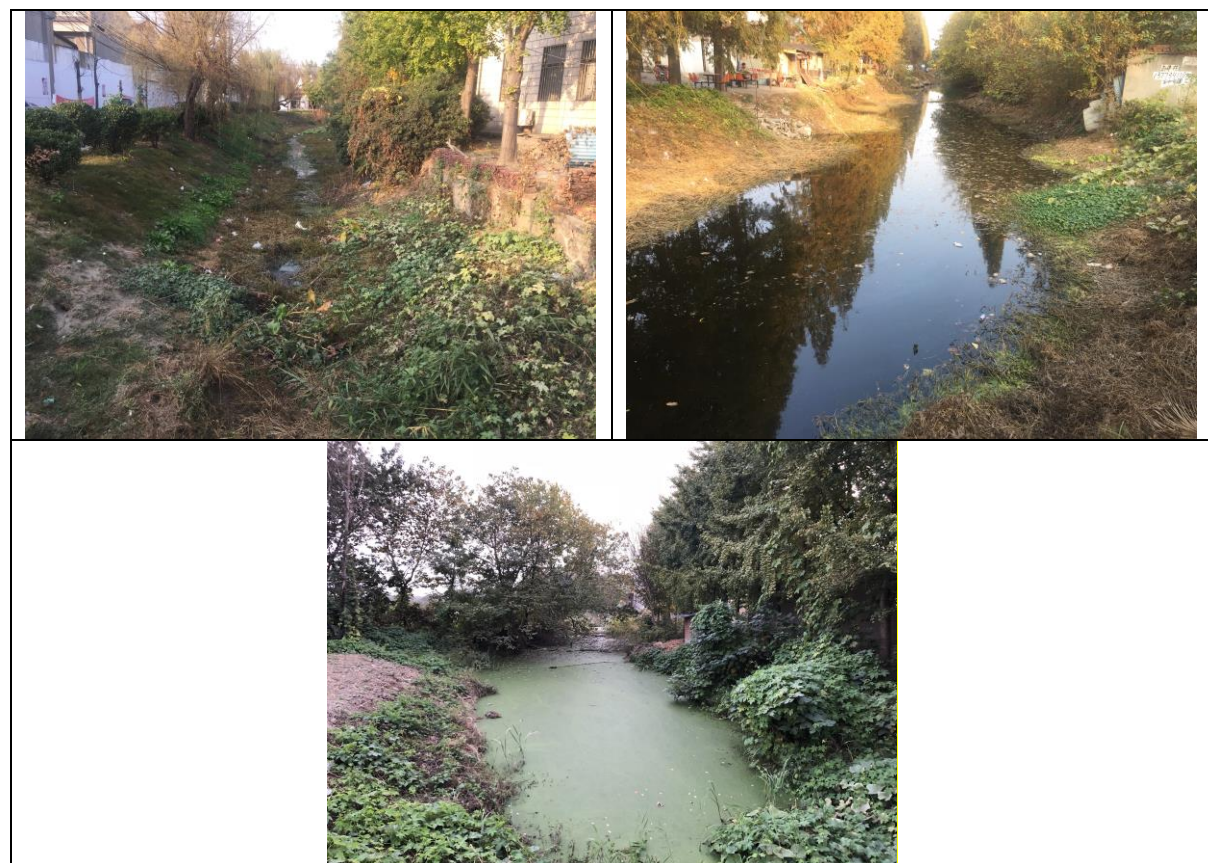
图 1-1 河道多处淤积严重、杂草丛生现状图
