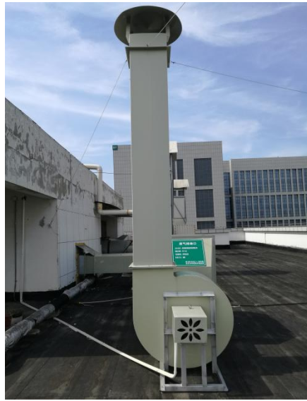
废气处理活性炭吸附装置及排气口
