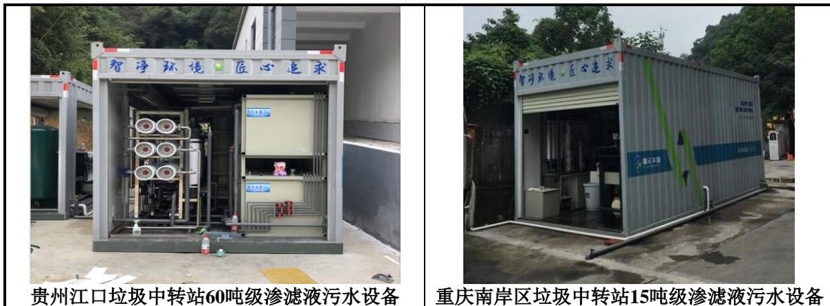
贵州江口垃圾中转站60吨级渗滤液污水设备
