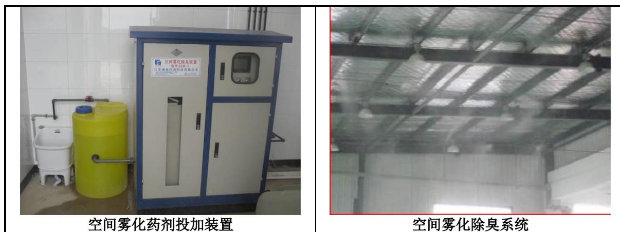
图8-5 无组织废气污染防治措施示意图
