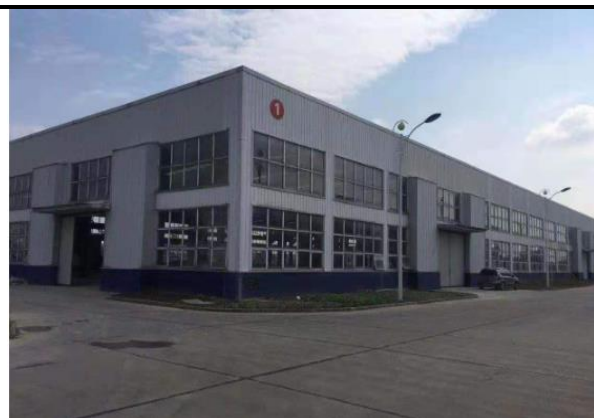
厂房外部现状图
