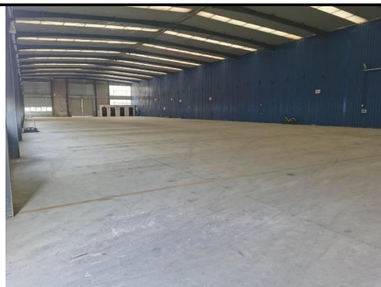
厂房内部现状图
