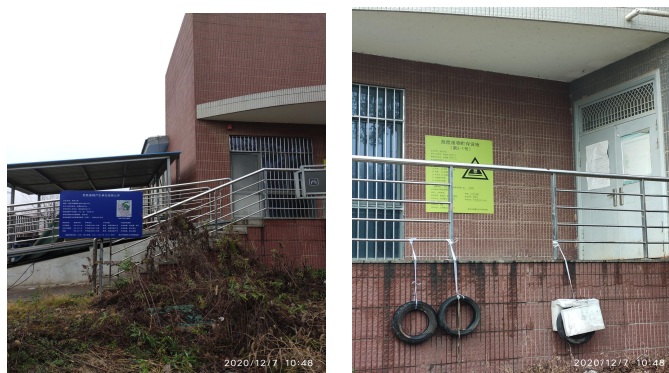
图 2-2 校区现有危废暂存间照片
