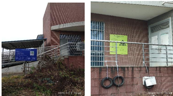
图 2-6 校区现有危废暂存间照片
